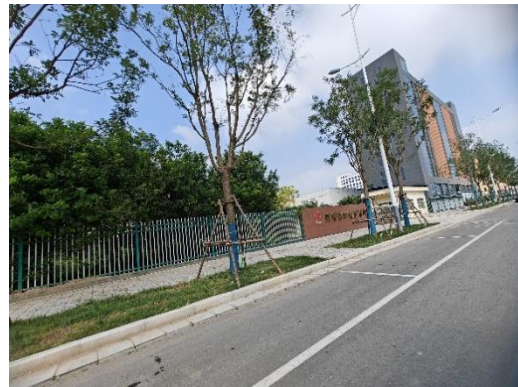
原点西三路透水砖铺装（2023年10月6日）
