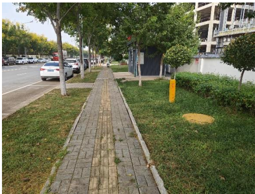
泾干一街透水铺装 (2023年10月6日)
