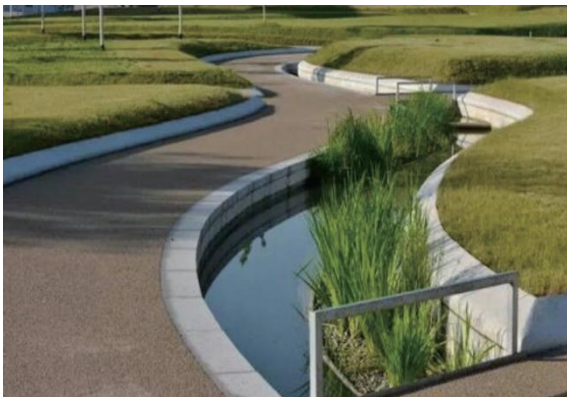
人行道透水铺装
