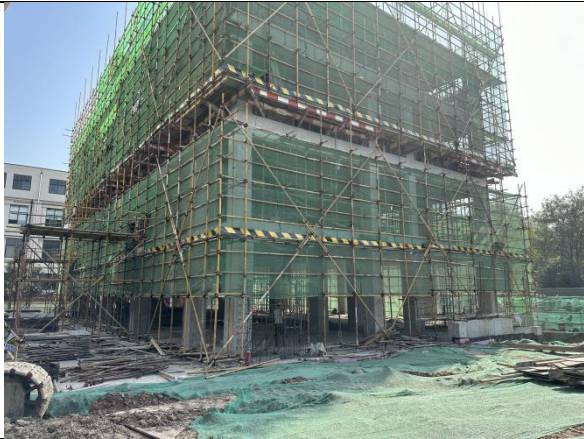
办公楼建设现状
