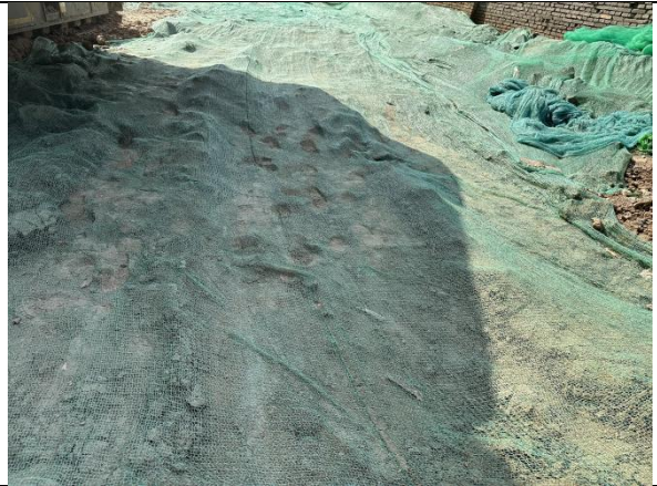
道路苫盖现状
