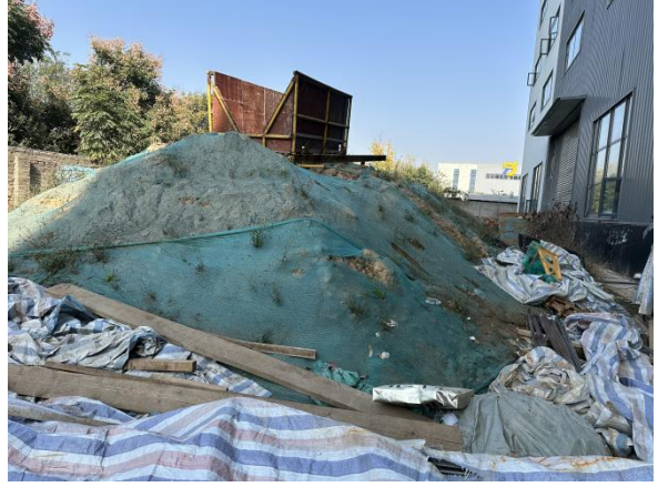
临时堆土区苫盖现状
