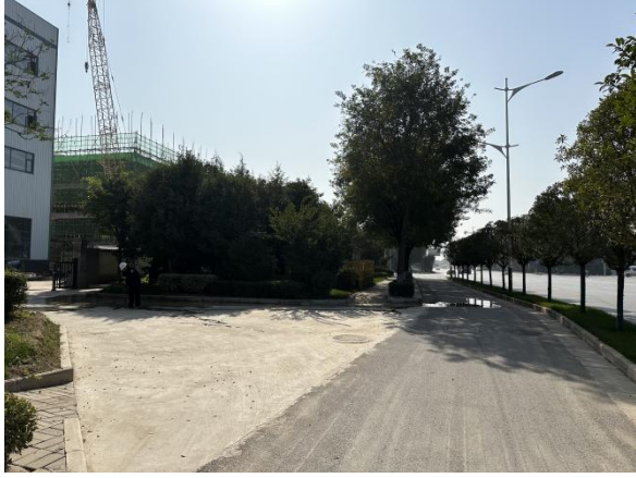
项目区接市政道路现状
