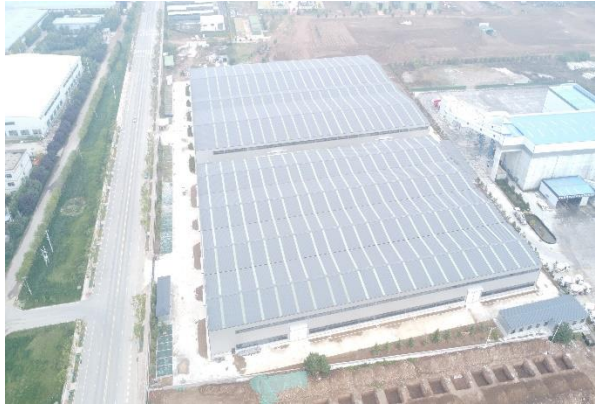
项目建设整体现状（2023年10月30日）
