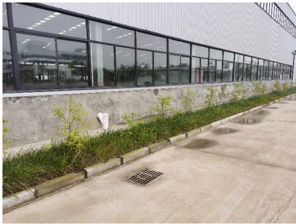
厂房周边雨水管网和雨水口 （2023年10月30日）
