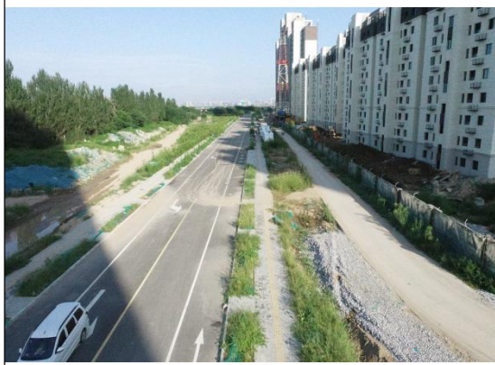
新建道路工程（已开工路段）2023.09.04
