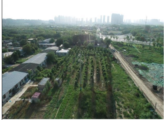
新建道路工程（未开工路段）2023.09.04
