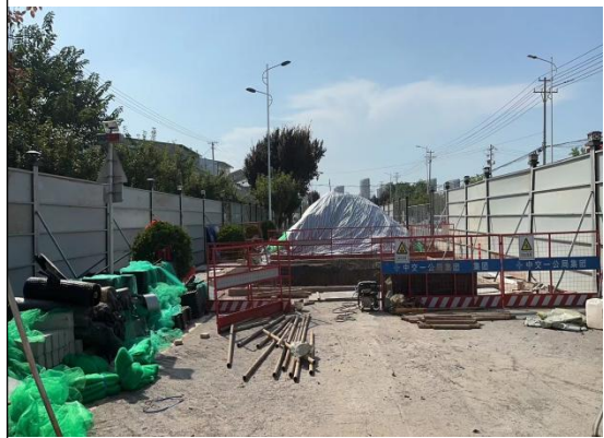
管网工程（施工路段）2023.09.04
