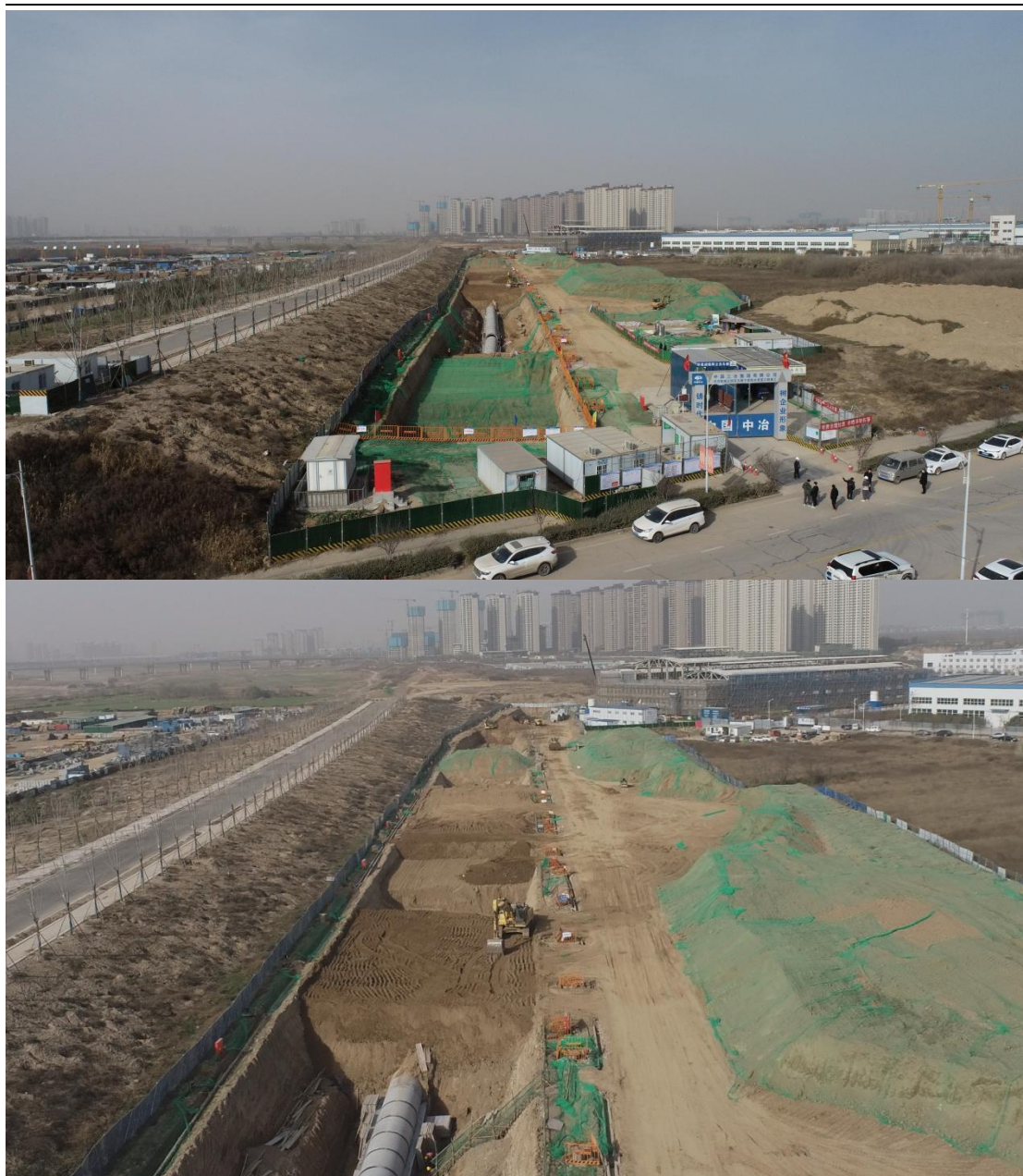
图 3.1-6 正阳东五路及下游排水工程建设现状
