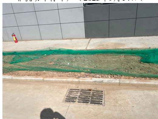
雨水排水管网（2023年9月14日）
