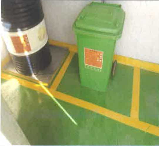
危险废物暂存间防渗防腐地面
