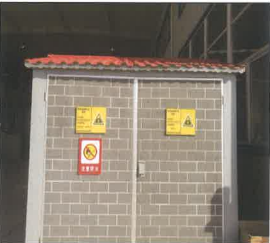
危险废物储存间
