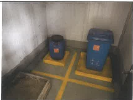
危险废物暂存间地面防渗处理
