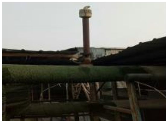
蒸压釜消声器
