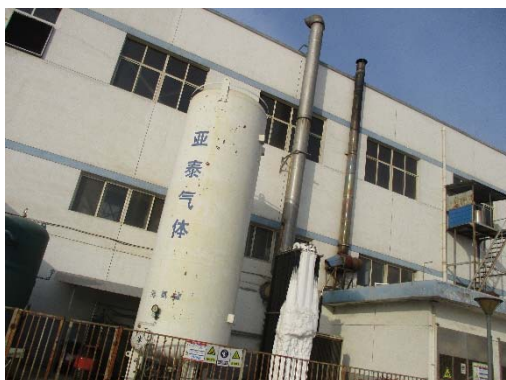
现有氮气罐及淬火油烟排气筒
