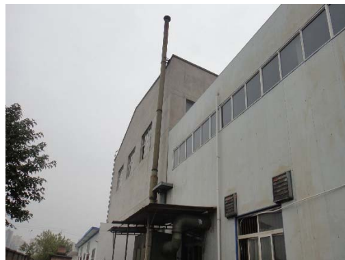
现有抛丸机袋式除尘器及排气筒
