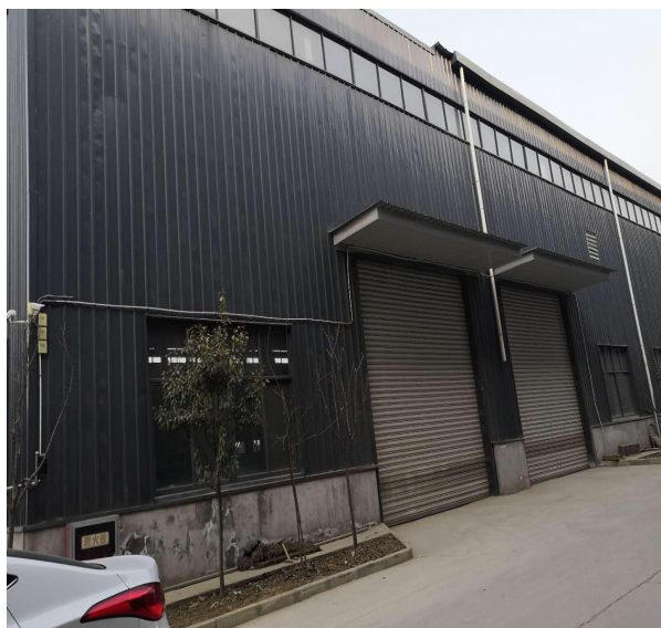
项目南侧厂房
