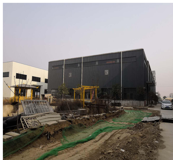
项目东侧厂房
