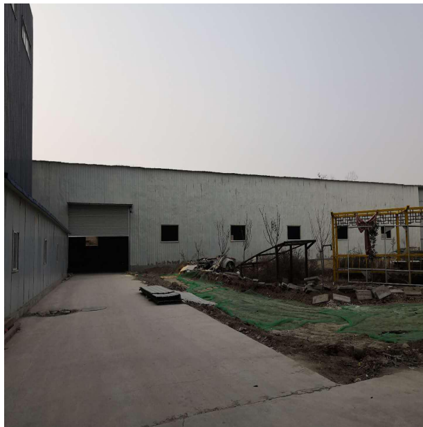
厂房外部现状
