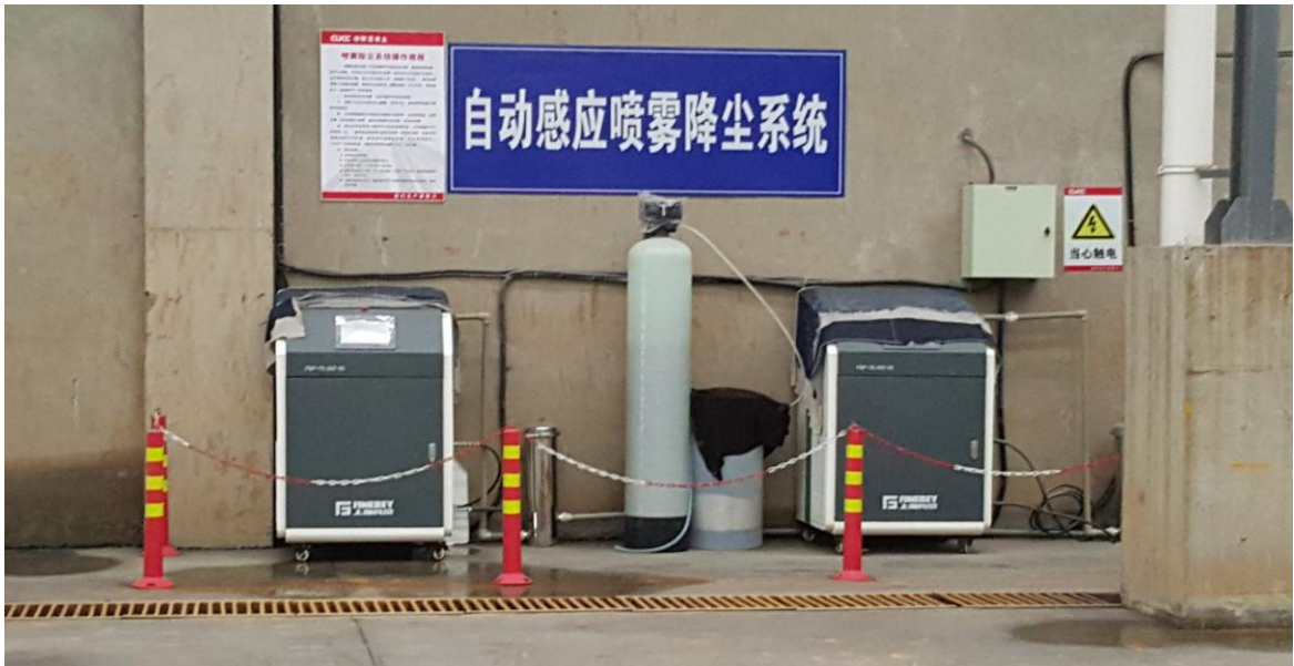
图 4-3 自动感应喷雾降尘系统
