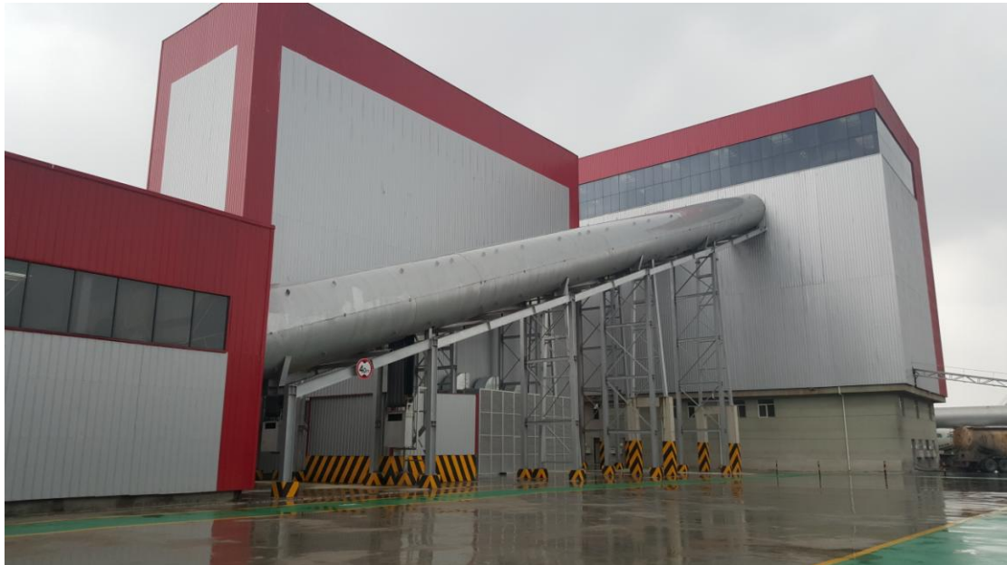
图 2-1 封闭式混凝土搅拌系统
