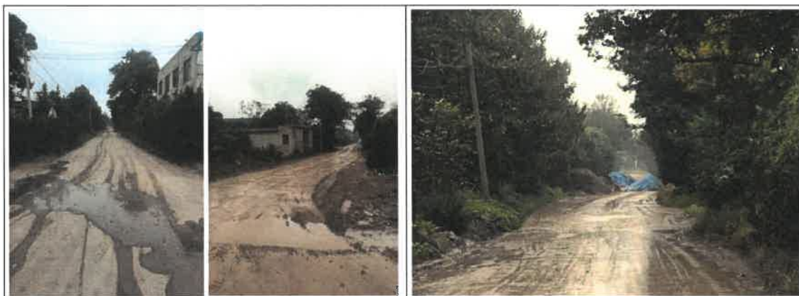
辅道道路硬化工程道路扬尘现象
