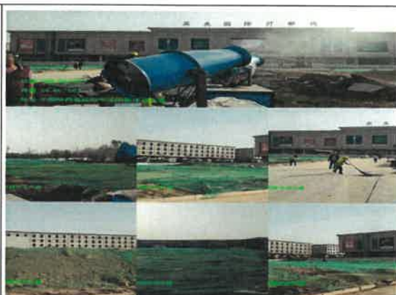
对裸露黄土覆盖后，雾炮已开启
