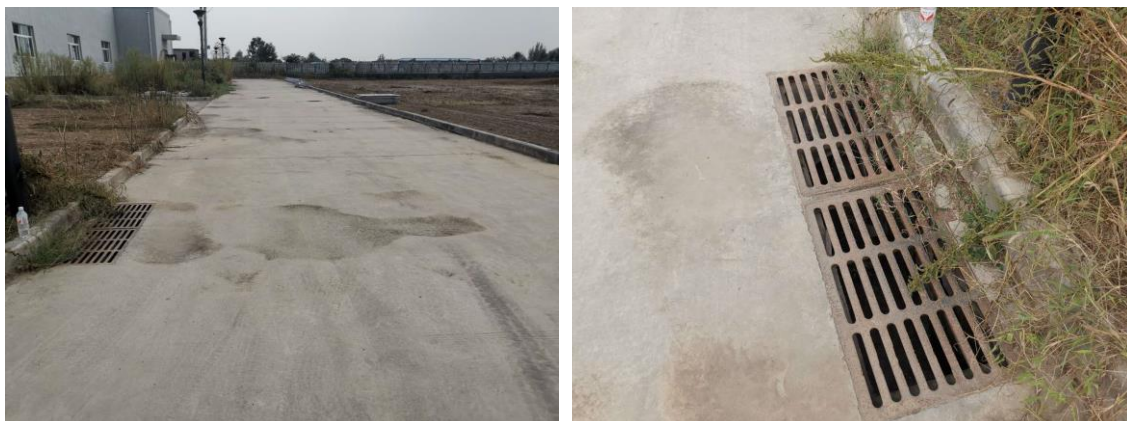
厂区现状道路及排水
